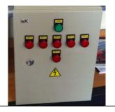
Система предотвращает холостой ход насоса (подкачка воздуха), и предупреждает (световая и/или звуковая сигнализация) о минимальном уровне жидкости в накопительной емкости. Также система может предупреждать о максимальном уровне
